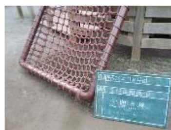
定期点検②
