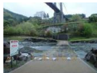
通行止めの措置
